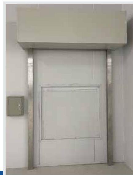
Bảo vệ cửa thang chống cháy
