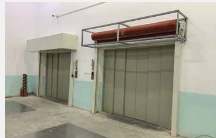
CÁC GIẢI PHÁP CUỐN SẬP CHỐNG CHÁY E CHO THANG MÁY
